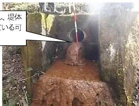
底樋出口(堤体下流)
