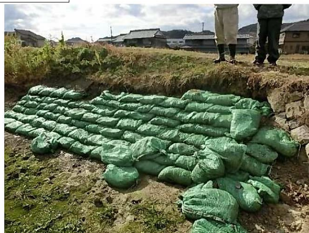
堤体上流法面に土のう設置
