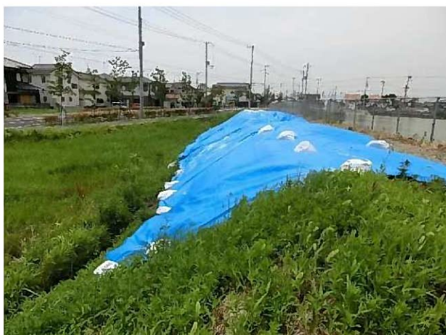
堤体下流法面にブルーシート設置
