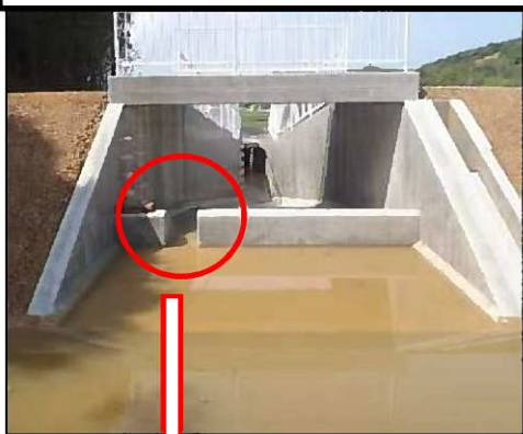
【南あわじ市 洪水吐越流堰の切欠き】
