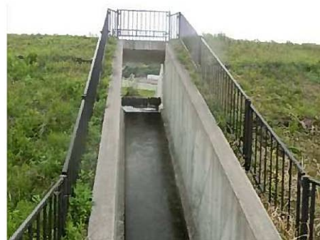
洪水吐(下流側)
