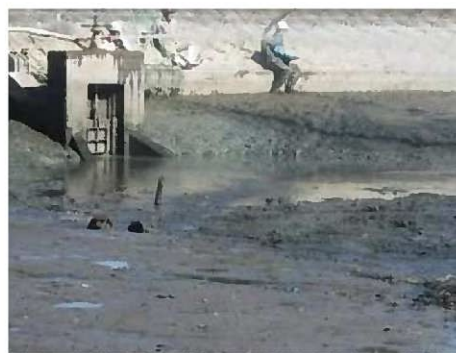
泥土除去後の状況(かいぼり実施後)
