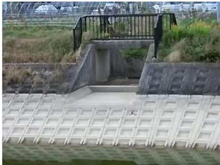
洪水吐(上流側)
