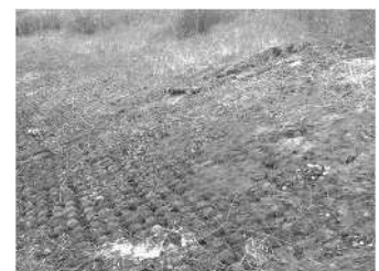
水位が低下したため、法面の状態を目視確認
