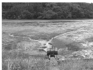
土砂吐ゲートを開放し、池干しを行っている様子
