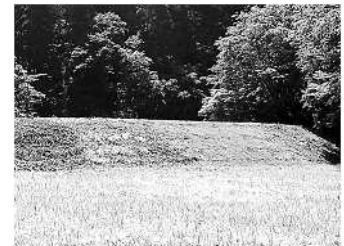
堤体の草刈りが行き届いており、変状の発見が容易
