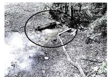
堰板設置により土砂も堆積し、堤体越流の危険大
